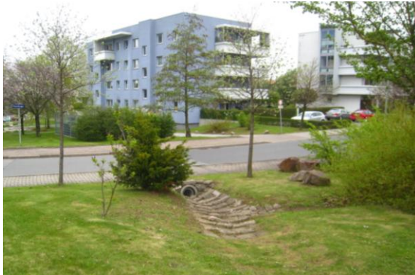
Regenwassereinleitung in eine Rasenmulde (S. Rößler)
