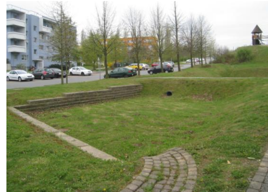
Regenwassereinleitung in eine Rasenmulde und Überlauf (S. Rößler)
