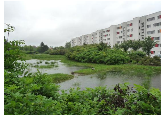
Eingestaute Versickerungsmulden im Naturpark Hetzdorfer Straße (Anschluss von ca. 4.700 m 2 Dachfläche) (M. Hergert)
