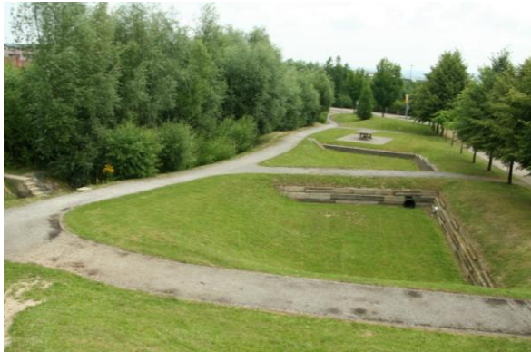
Kaskadenförmige Anordnung von Versickerungsmulden (H. Hensel)
