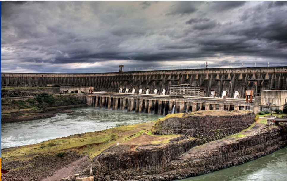
Itaipu Binacional, Brazil 巴西伊泰普水电站
